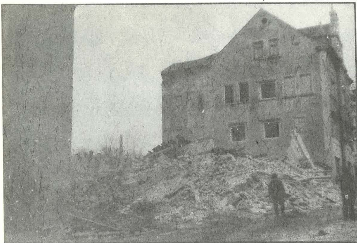
Obr. č. 12 - Situace po trhací práci
