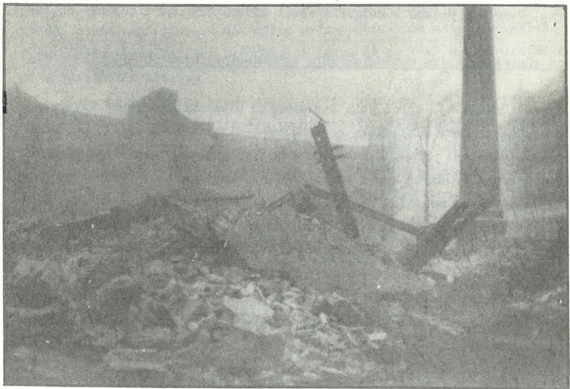
Obr. č. 14 - Situace po provedené trhací práci
