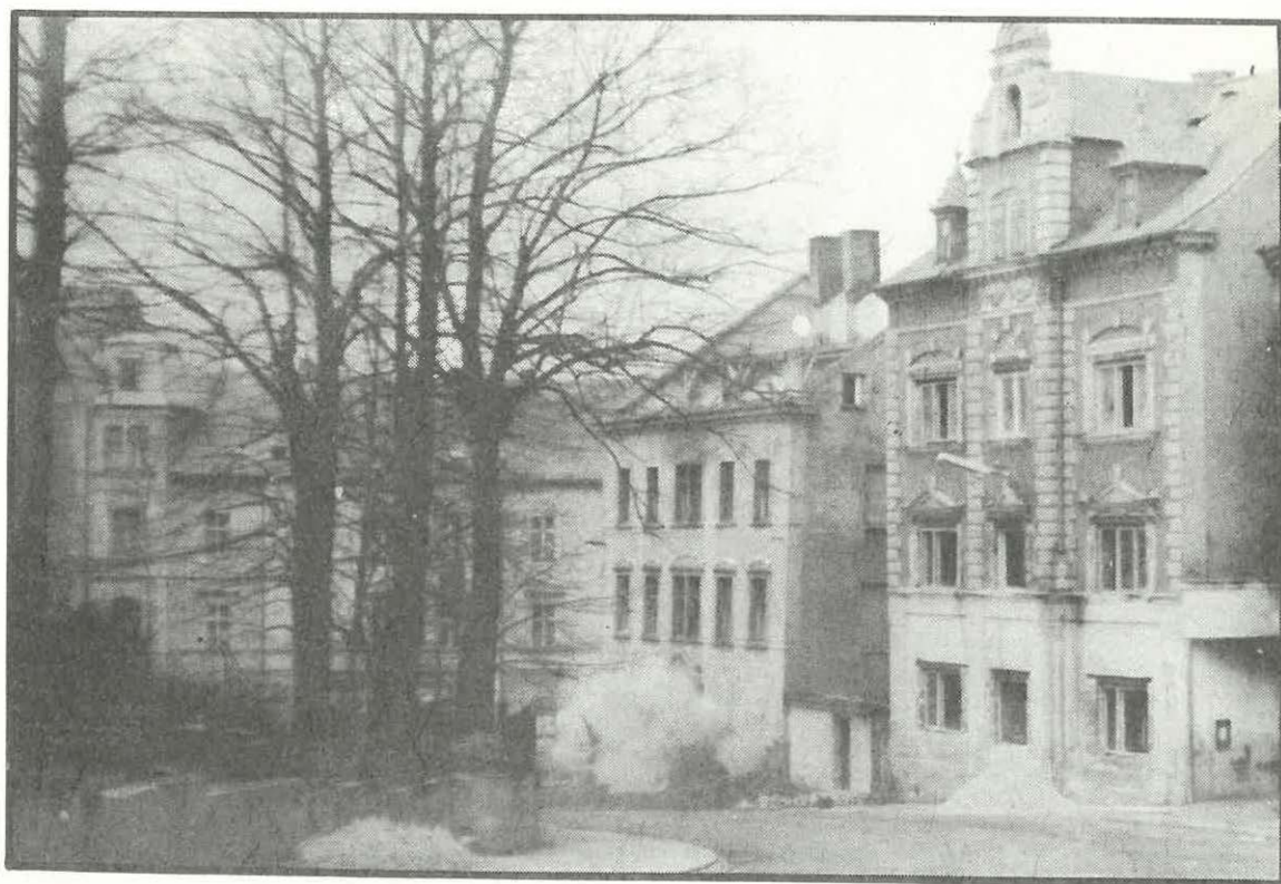
Obr. č. 10 - Odstřel dalšího obytného domu. Na snímku je patrné sklápění zdiva do žádaného směru
