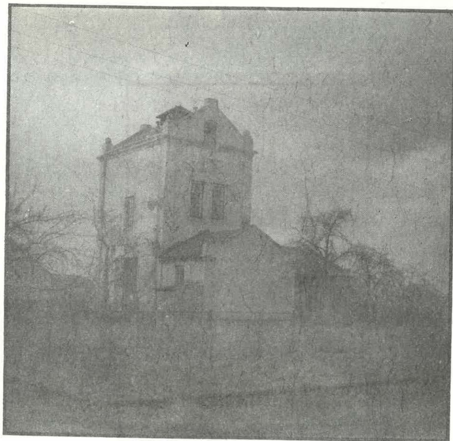
Obr. č. 1 - Důl Döllinger - povrchový objekt vodotěžné jámy
