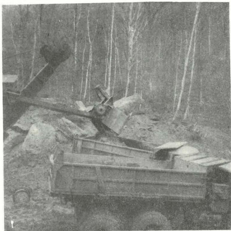
Obr. 13 Lopatové rypadlo při dobývání kamenitých sutí
