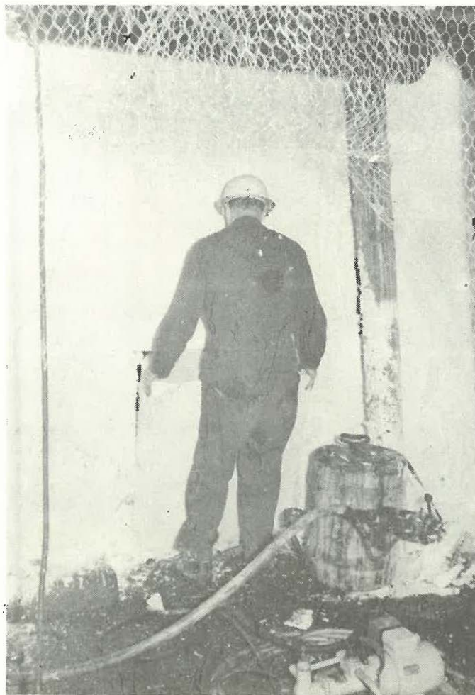
Obr. 3 - Vložení posledního bloku
