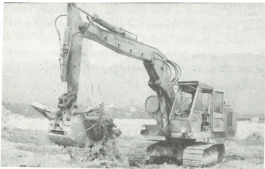
Obr.č. 2 Hydraulické rypadlo CASTOR 602 na skryvkovém řezu s upravenou hloubkovou lopatou na svahování prováděných odvodňovacích příkopů
