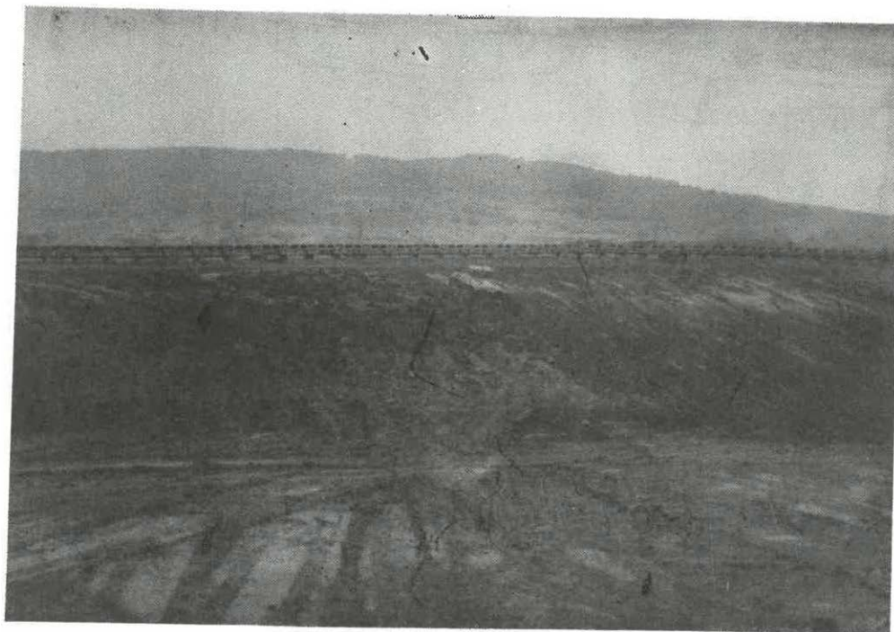
a/ Úprava svahu pro přestavbu
