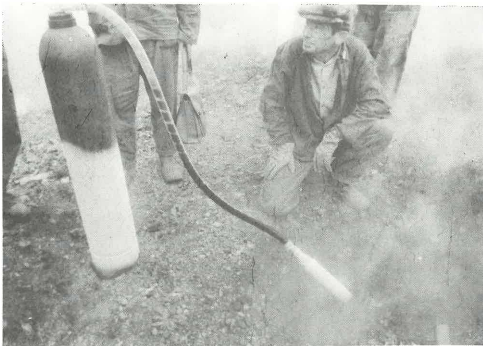
Napouštění vrtu kapalným \text{CO}_2
