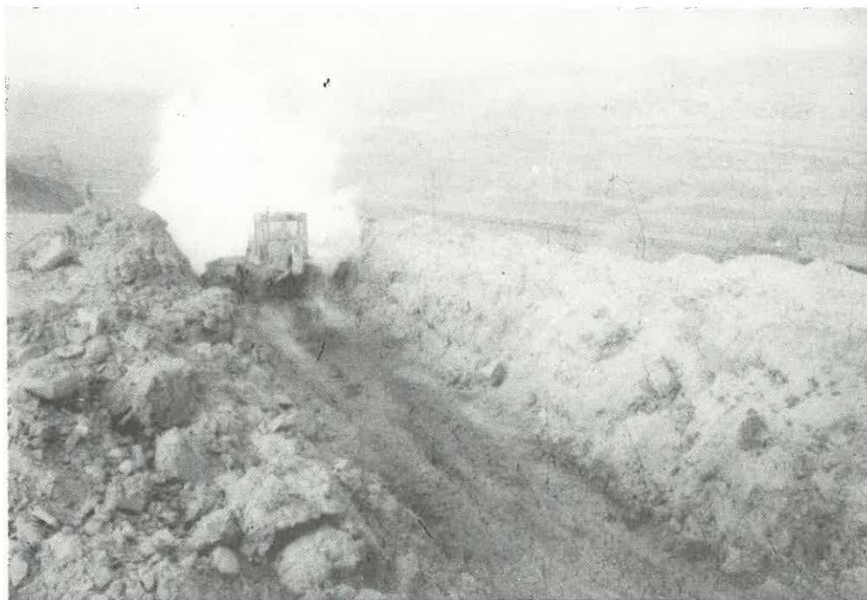
Prohlubování zářezu buldozerem
