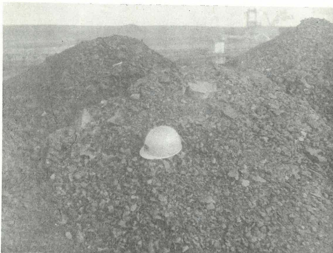
Obr. 4 Kusovitost těživa dobývaného kombajnem ČUK-171
