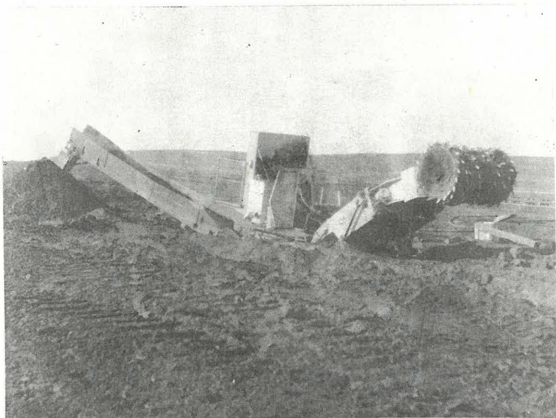
Obr. 2 Kombajn ČUK-171 při tvorbě zářezu v lomu _ Březno
