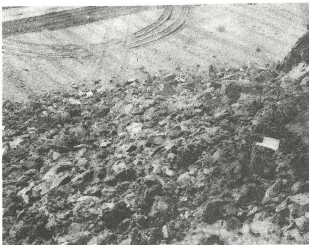
Sesutí lomové stěny skrývkového řezu Trhavina Emsit
