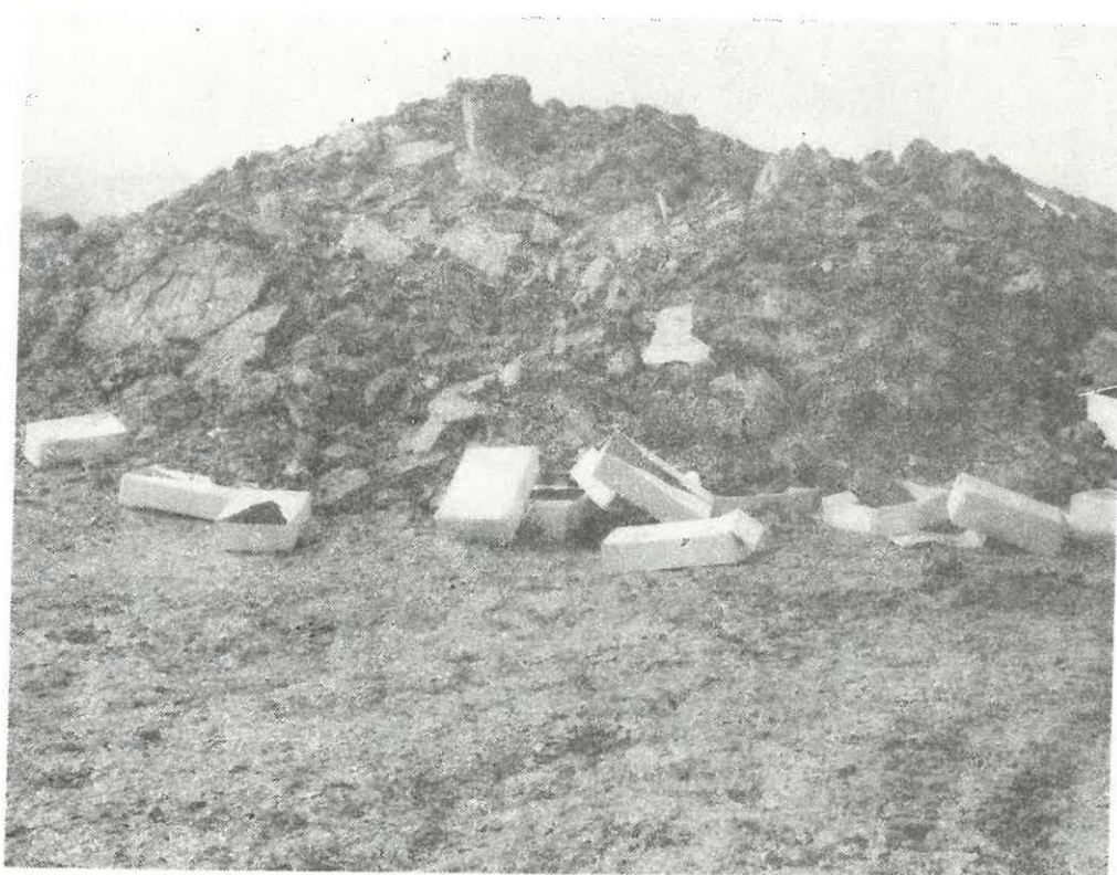
Nakypření u odstřelu s roztečí 4x4m - skrývka Pokus s trhavinou Emsit
