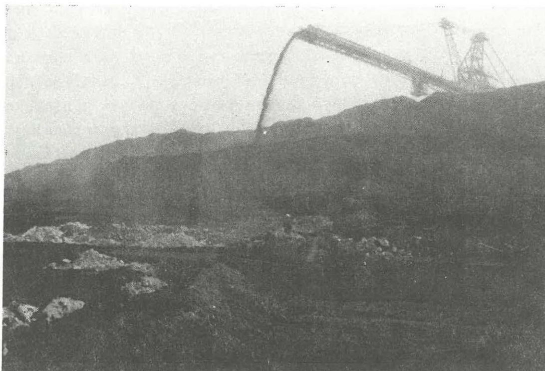
Celkový pohled na sypání I. vrstvy
