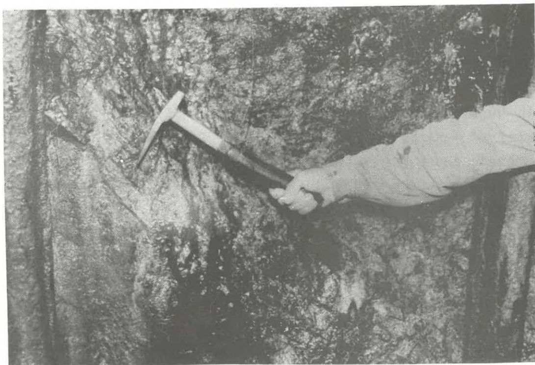
Obr. 5 - Vývěry vody z poruchového pásma ve staničení 243 - 246 m; štola Jezeří
