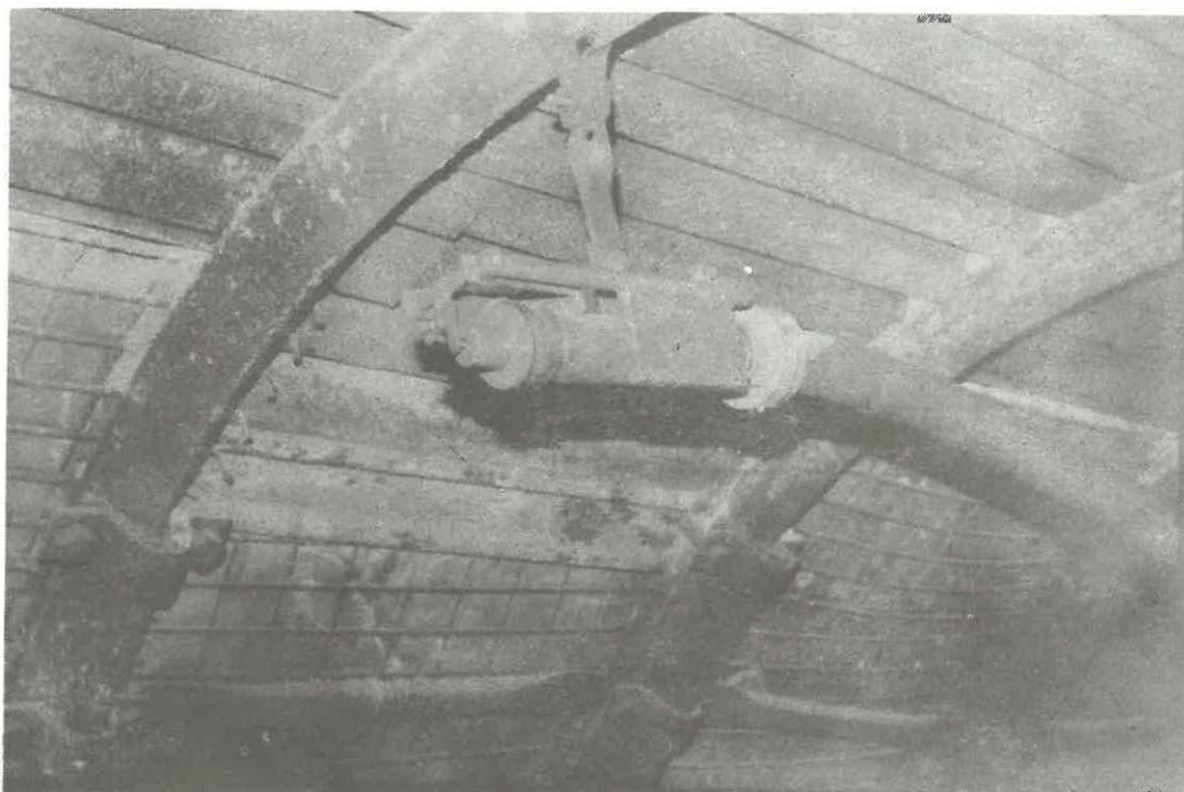
Obr. 1 Automatická mlhotvorná proudnice
