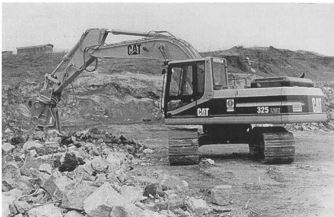
Obr. 4 Výkonné hydraulické rýpadlo na housenicovém podvozku CATERPILLAR CAT 325 LME vybavené hryzačem od fy PHOENIX-ZEPPELIN
