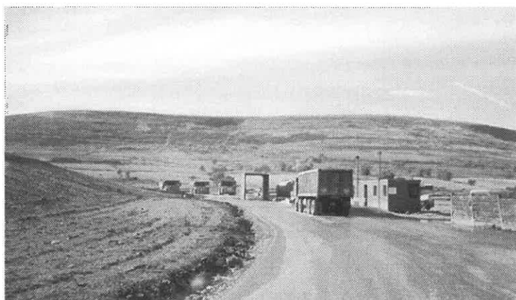
Obr. 4 Pohled na výjezd z dolu Ffos Las (J. Wales), v centru snímku je kolesová vodní myčka nákladních vozů, které vyjíždějí z prostoru dolu na veřejnou komunikaci, vlevo deponie svrchní vrstvy půdy, sloužící jako pastvina, v pozadí jižní svahy Kambrických vrchů.
