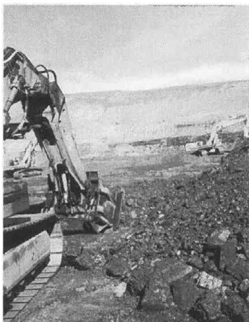
Obr. 3 Dno uhelného lomu Ffos Las v Jižním Walesu. Čištění narubaného antracitu.
