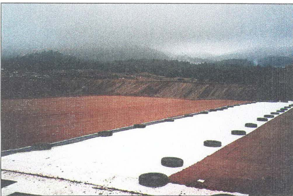
Obr. 1 Výstavba skládky stabilizátu pro Elektrárnu Tisová (ČEZ) v r. 1995. Minerální těsnění je z terciárního bentonitického jílu Dasnice (SU).
