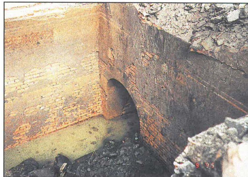
Obr. 3 Zděná retenční nádrž pod jámou Žofie s vodní chodbou
