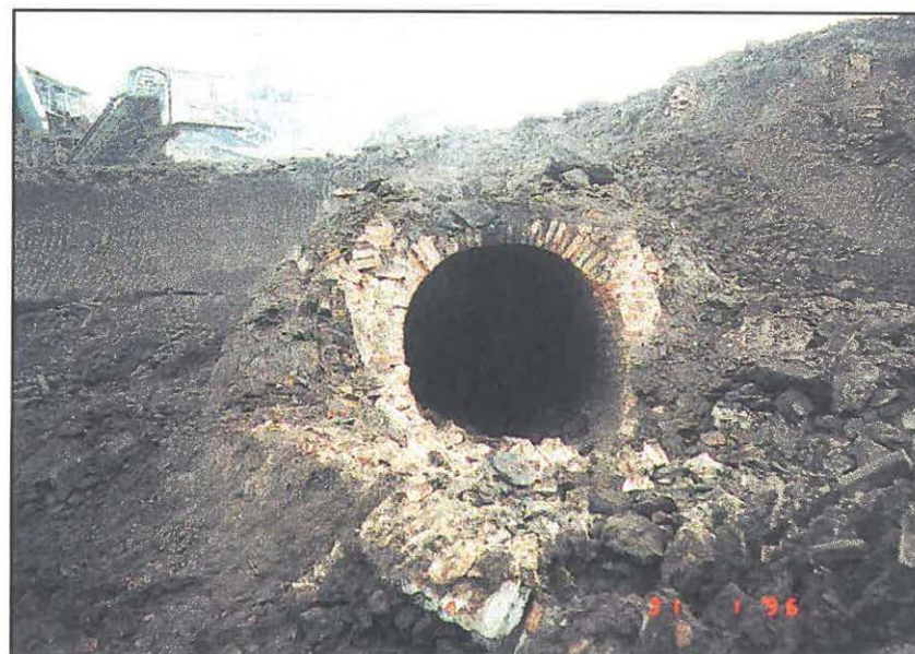
Obr. 5 Kruhová vodní chodba ústící do retenční nádrže
