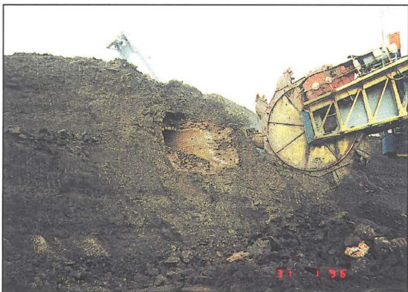
Obr. 4 Těžba rýpadlem K 300/32 v piliři s chodbami
