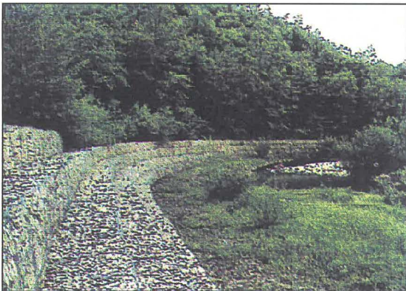
Obr. 6 Aplikace gabionů (ekokoše)
