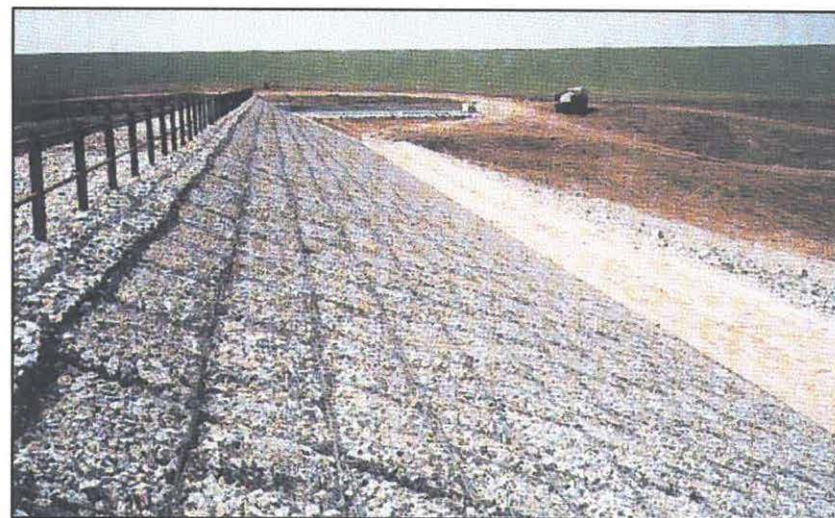
Obr. 7 Aplikace gabionů (ekomatrace)
