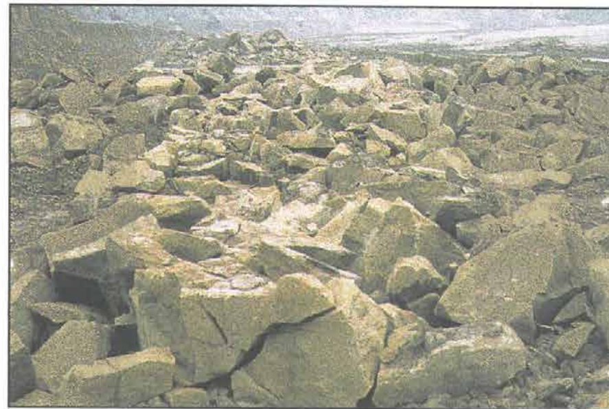
Obr. 12 Sekundárně dezintegrované pískovce pomocí hydraulického kladiva na pláni rýpadla K 2000
