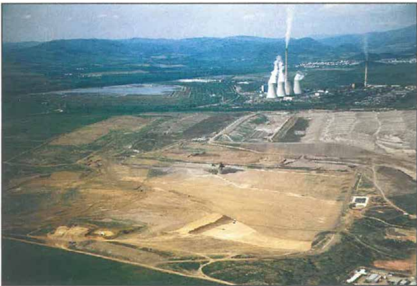
Obr. 3 Pohled z ptáčích perspektivy na skládkový areál "Stodola", kde jsou ukládány pevné odpady ze spalovacích procesů sousední tušimické elektrárny
