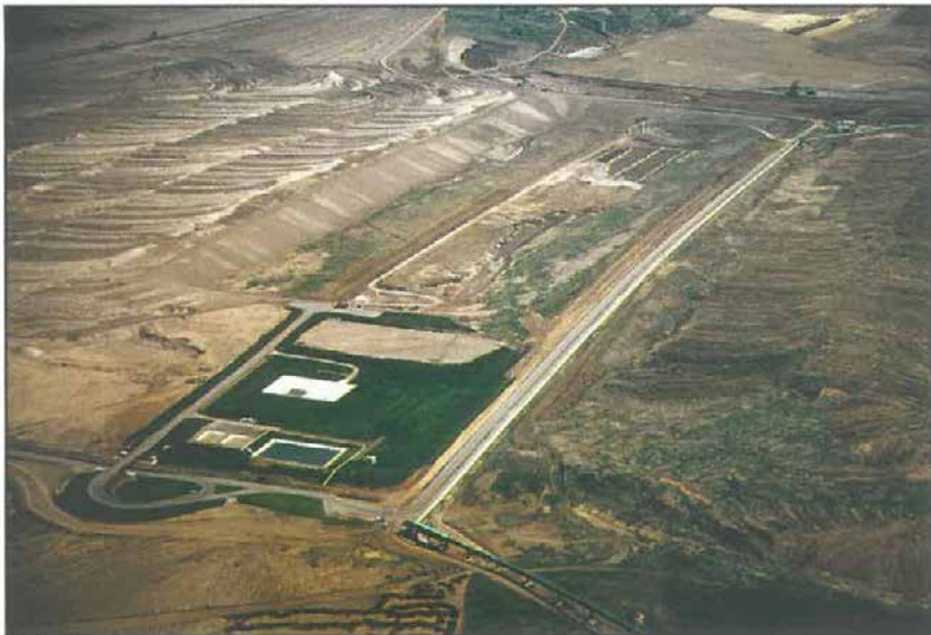
Obr. 1 Letecký pohled na celkovou situaci skládky tuhých průmyslových odpadů, která byla výhodně umístěna na výsypce lomu Libouš
