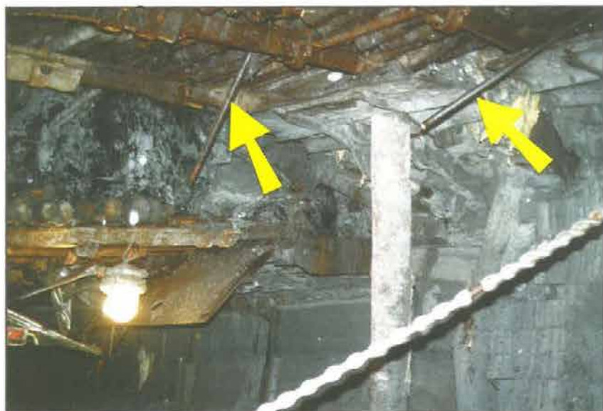
Obr. 3 Pracné čištění a obnažování sekci, znázorňující provedení nainjektování nad sekcemi
