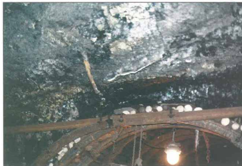
Obr. 2 Nainjektovaná a obnažená část stropu po injektáži
