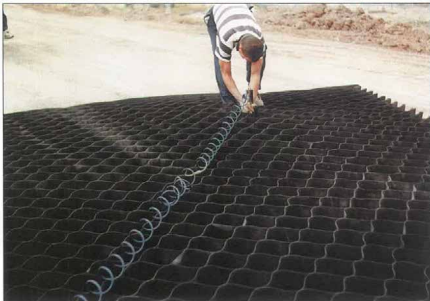
Pokládka a zavážení zpevňujícího systému GEOWEB
