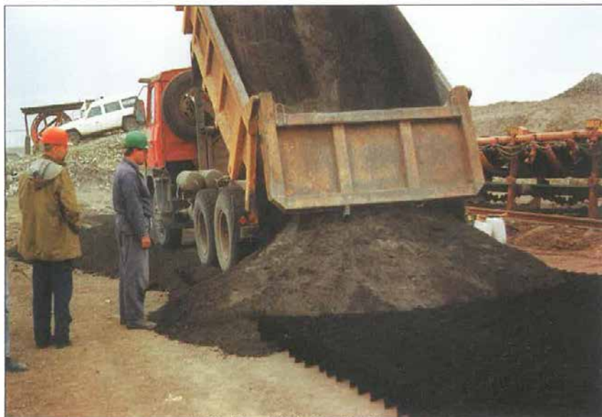
Pokládka a zavážení zpevňujícího systému GEOWEB
