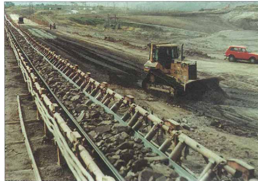
Rozhrnování, hutnění a přivlhčování konstrukčních vrstev vozovky
