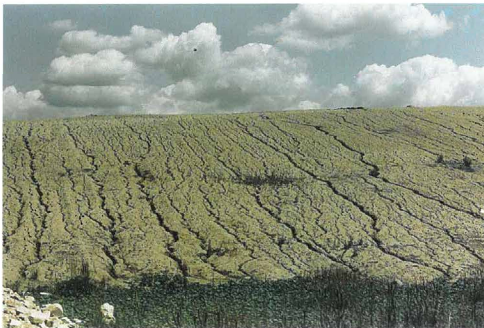
Obr. 1 Rýhová eroze na technicky upraveném povrchu výsypky
