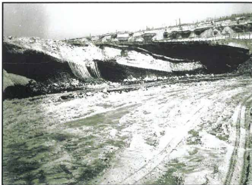
Obr. 1 Hnědouhelná sloj Josef s nepravidelným uložením, vyvinutá ve dvou lávkách a nahoře hnědouhelná sloj Anežka, poznamenaná hlubinou těžbou bývalého hlubinného dolu Anežka v Lískové
