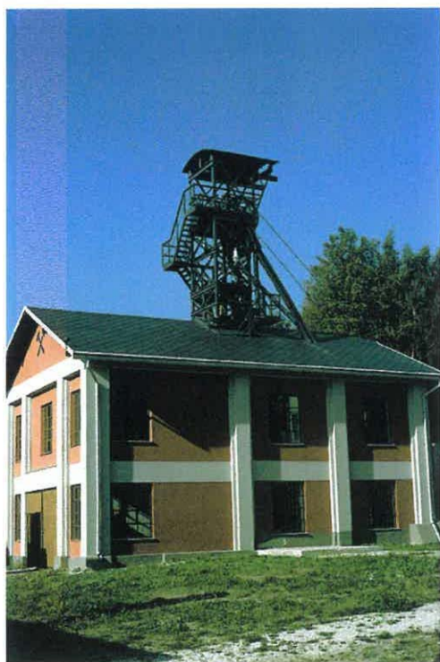
Šachetní budova s těžní věží dolu Vilém (2000, foto P. Beran)
