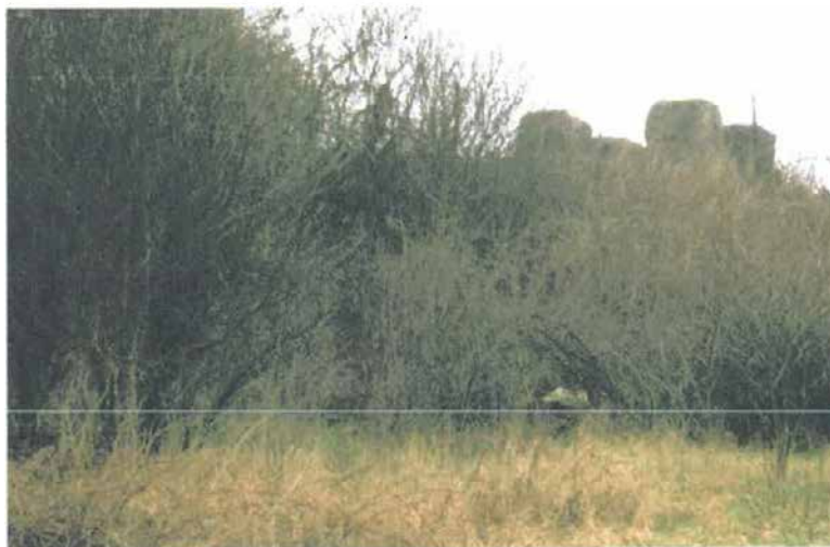
Příloha 3 Foto zbytků báňské stavby – pilířů třídícího zařízení
