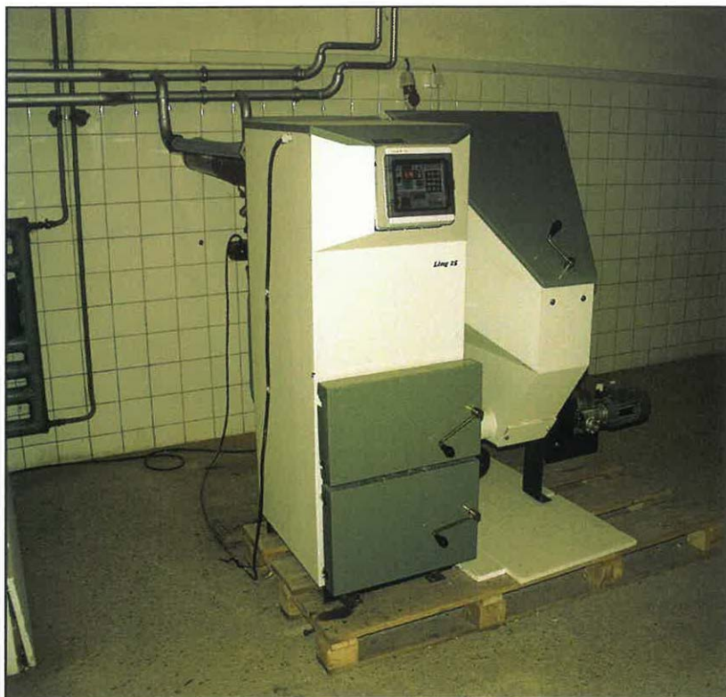
Obr. 3 Kotel Viadrus Ling 25
