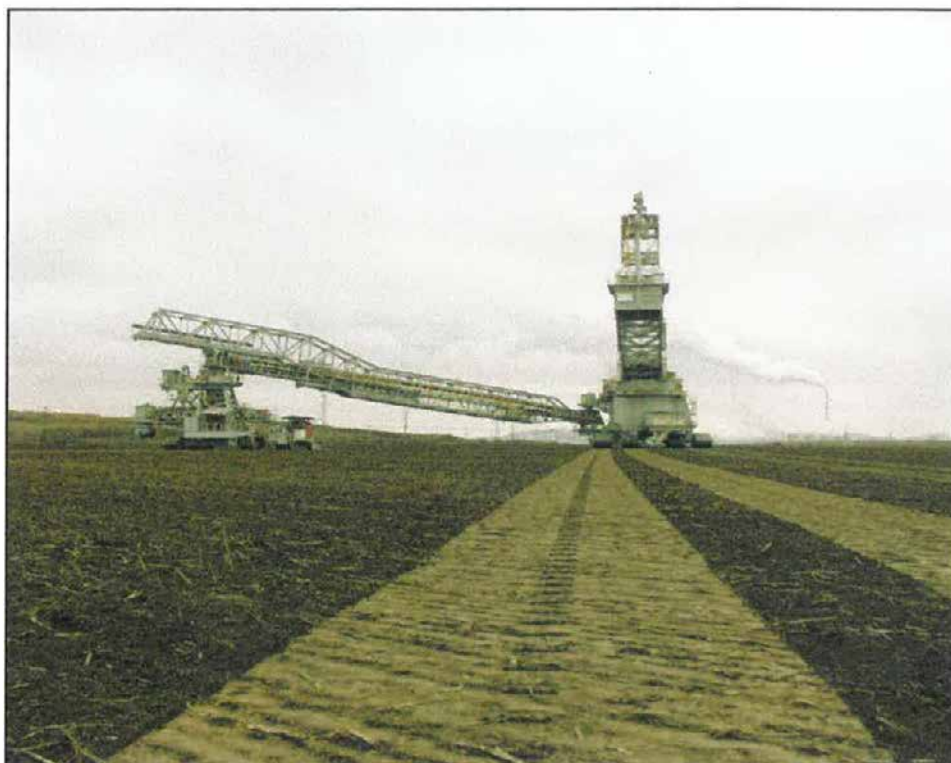
Rýpadlo na cestě do dolu (14.12.2001)
