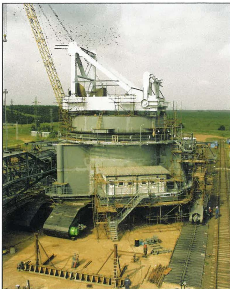
Fáze montáže spodní stavby (5.06.2001)
