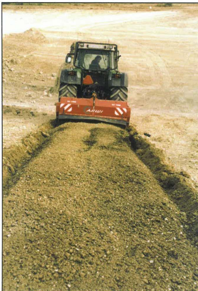
Traktorový nosič FENDT 926 VARIO s mulčovací frézou AHWI, představuje dokonalou technologii homogenizace zeminy až do celkové hloubky 0,4 m
