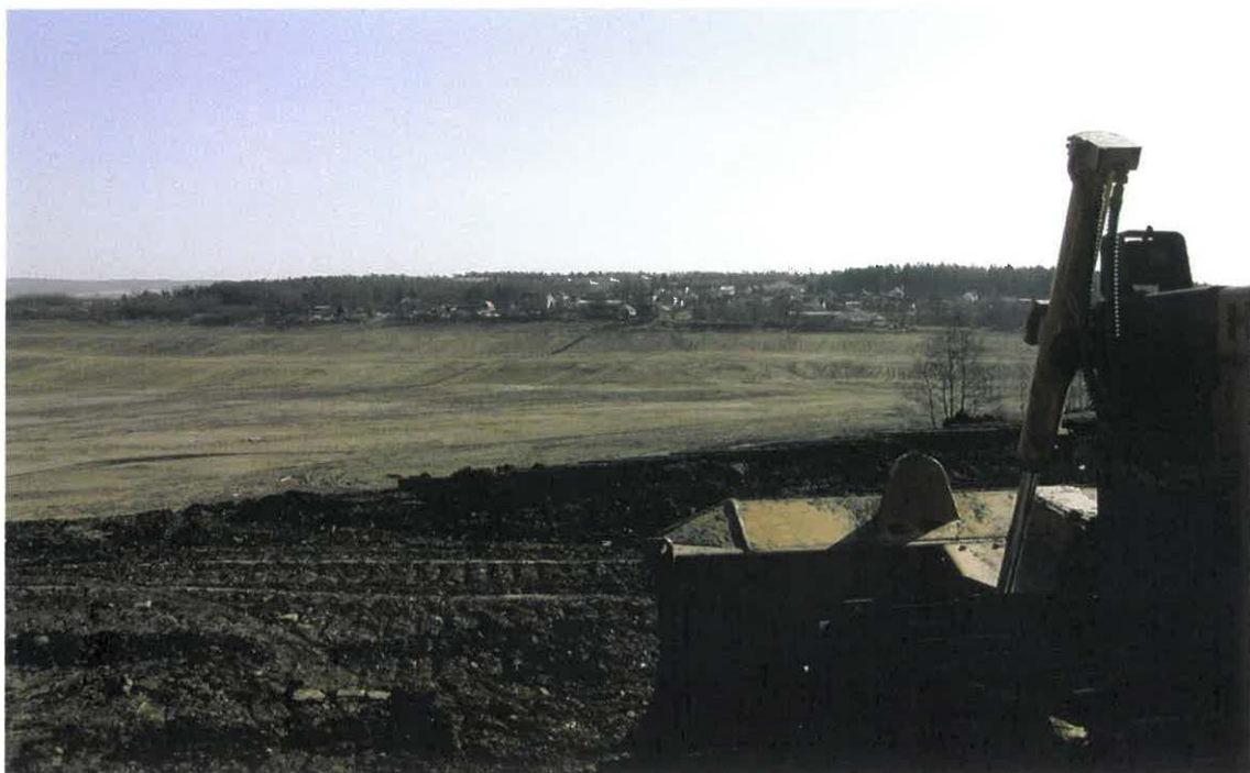
Konečná terénní úprava severozápadních svahů pod Bukovanami
