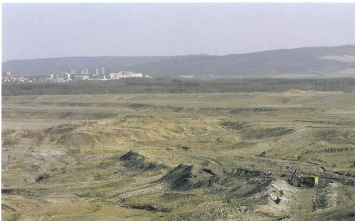
Zakládání sanační skryvky je zatím prováděno lžicovými rýpadly E 2,5. V pozadí je na úpatí Slavkovského lesa patrný Sokolov.
