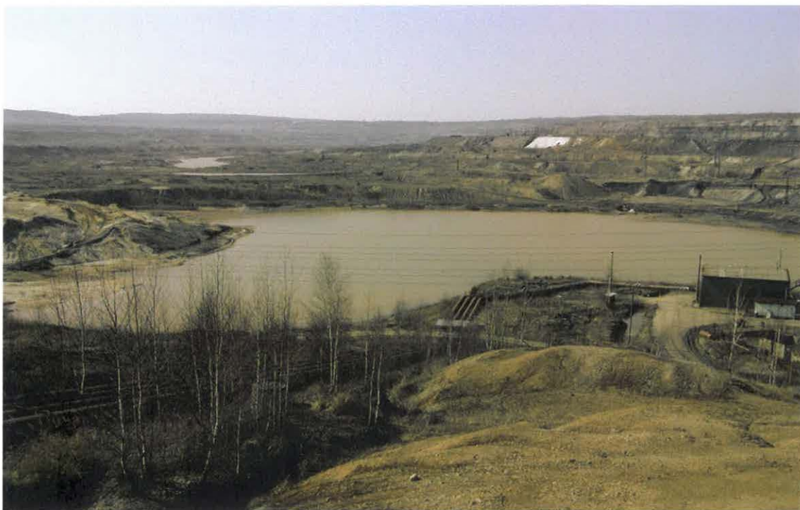
Podélný pohled přes dno lomu od východu k západu. V popředí retenční nádrž, čerpací stanice a výtlačné řady.
