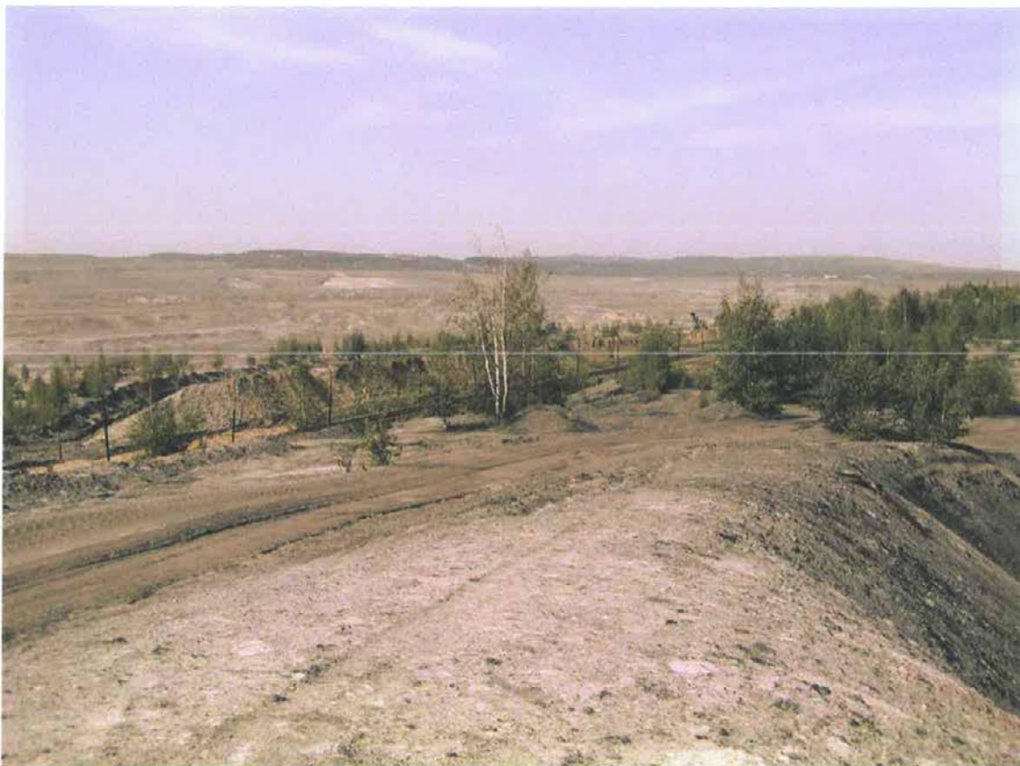
Obr. 3 Pohled ze severu na výsypkové svahy v západní části lomu (oblast profilů 8-8' a 9-9')
