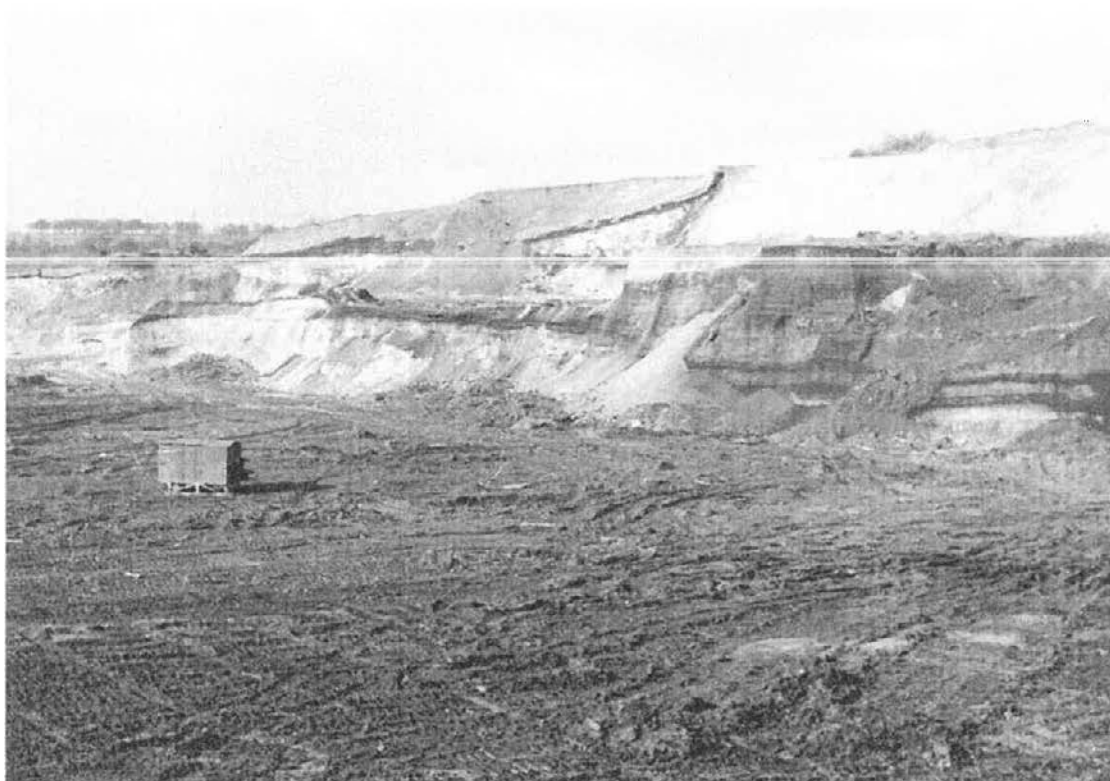
Obr. 8 Celkový pohled na sz. okraj vyuhlené páničky lemované na výchozu denudačním zbytkem zvětralé sloje (oxyhumolit) a překryté sprášení
