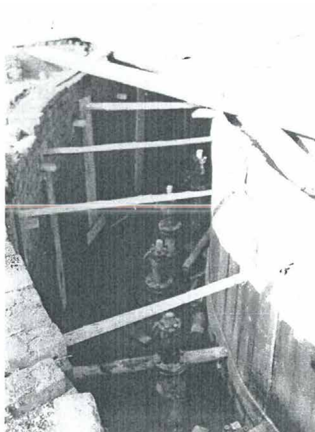
Obr. 5 Část přisklepi jámy se zmrazovacími armaturami
