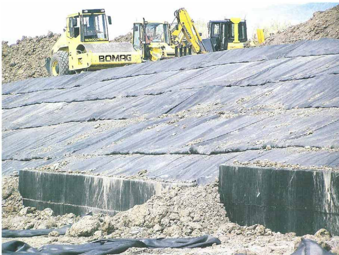
Obr. 2 Vyztužení svahu hutněnými vrstvami zemin 0,25 m s použitím geotextilie Bontec HS 70/70 (260g.m -2 )
