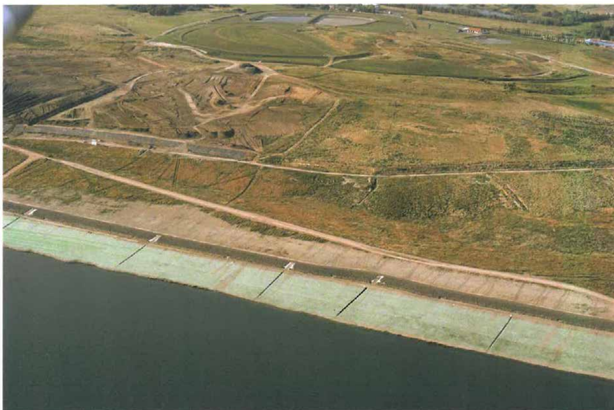
Obr. 4 Protiabrazivní opatření na březích jezera kamennými přísypy s použitím perforované geotextilie Envirofelt
