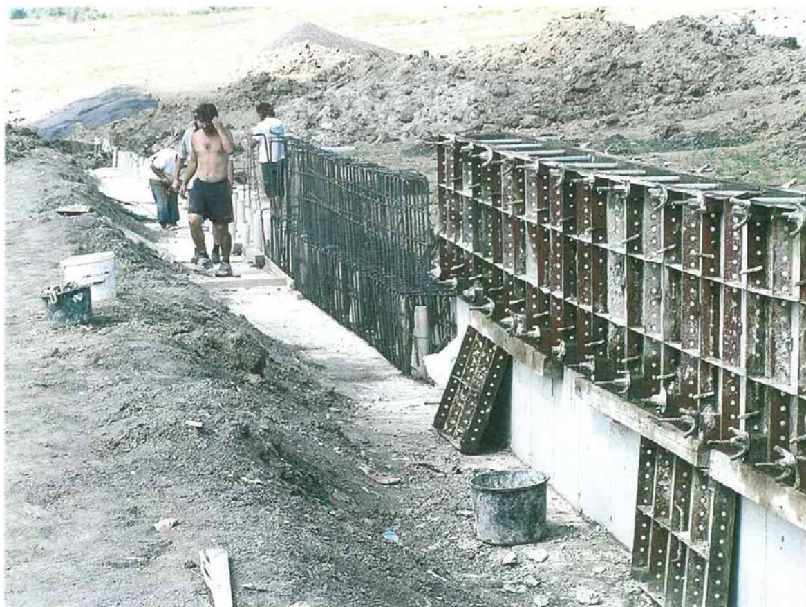
Obr. 1 Vyztužení patní části svahu mikropilotovou stěnou
