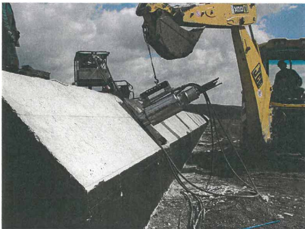
Obr. 5 – Zakotvení segmentu betonového trámce
