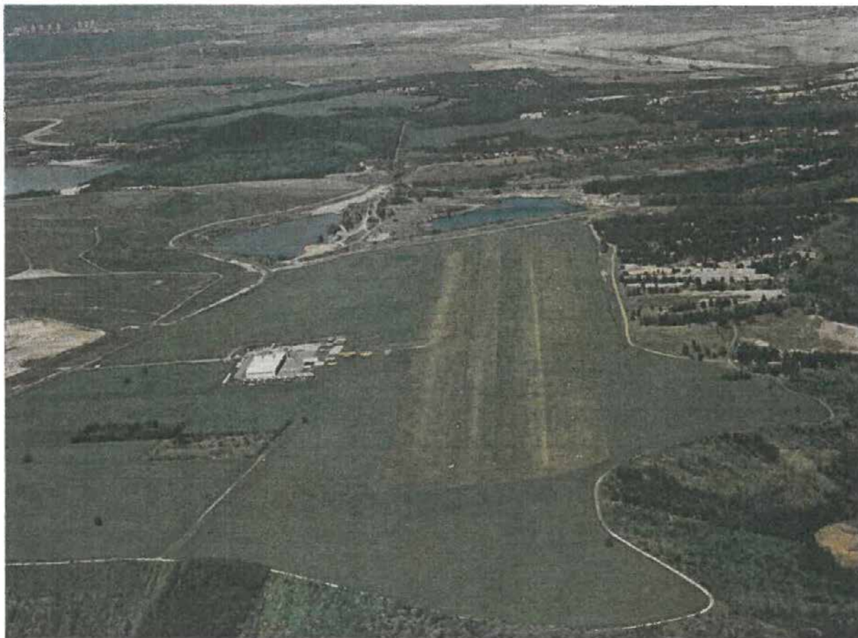
Obr. 4: Dokončená rekultivace výsypky Střimice
