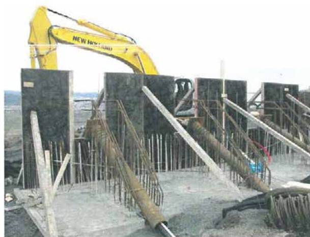
Obr. 1 – Stavba dilatačních celků s průchodkami pro kotvy
