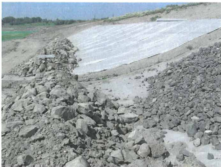
Obr. 2 – Zpevnění svahů kamenným pohozem na geotextilii Polyfelt TS
