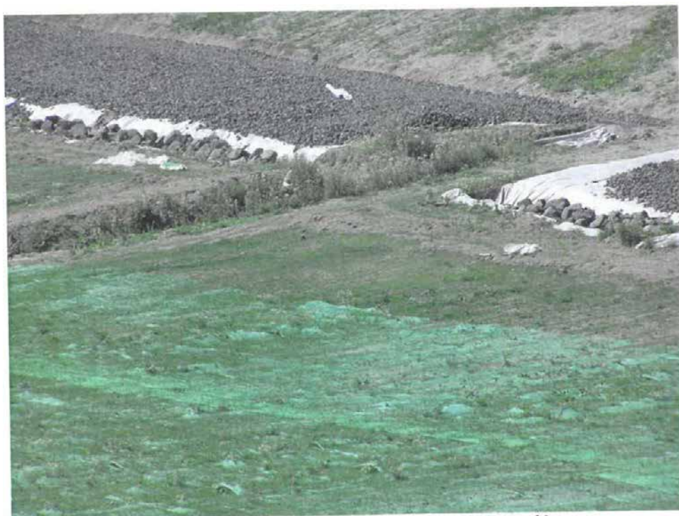
Obr. 1 – Prorůstání travního porostu geotextilií Envirofelt
