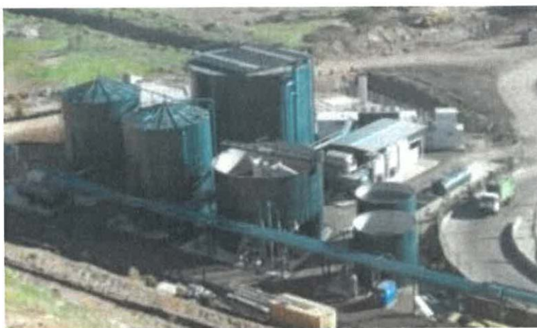
Obr. 1 - Dvojitá UASB anaerobická digestoř uzpůsobená pro úpravu odpadu a odpadní vody
