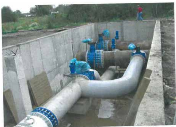
Obr. 3 - Rozdělovací šachta přivaděče z PVN
