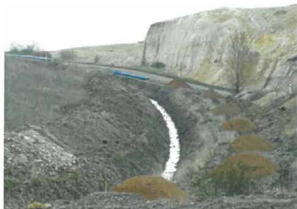
Obr. 8 - Výstavba přívaděče z MR1 do jezera Most
