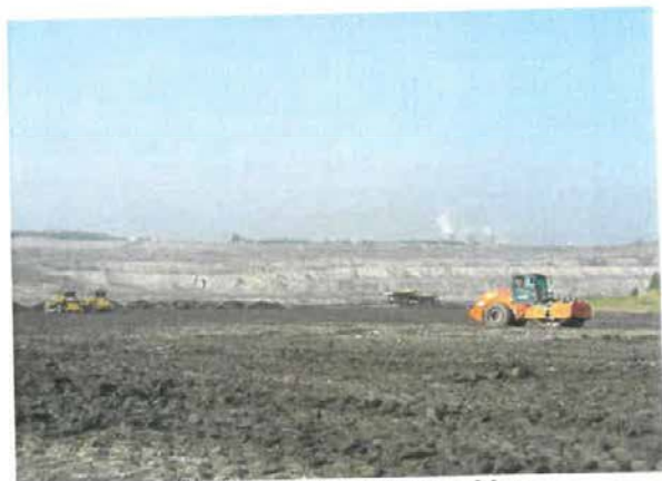
Obr. 9 - Těsnění dna jezera Most
