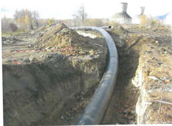
Obr. 2 - Začátek přivaděče z PVN – Třebošice
