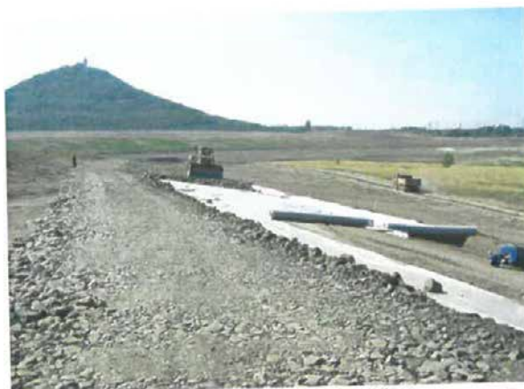
Obr. 10 - Výstavba břehové linie
