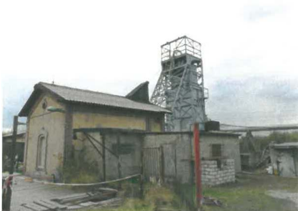
Obr. 7 - Čerpací stanice na jámě MR1
