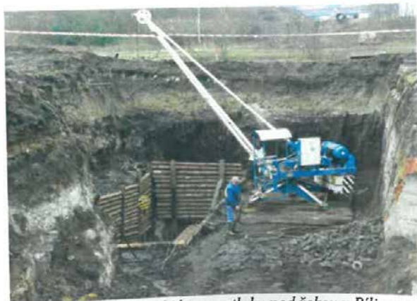
Obr. 4 - Startovací jáma protlaku pod řekou v Bílinou
