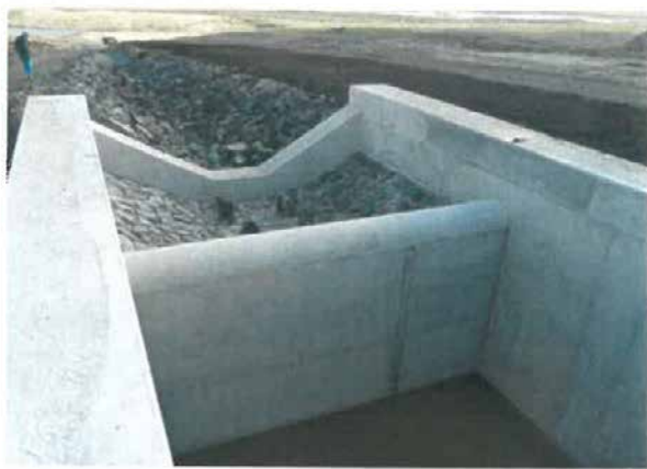
Obr. 5 - Uklidňovací nádrž na konci přívaděče z PVN
