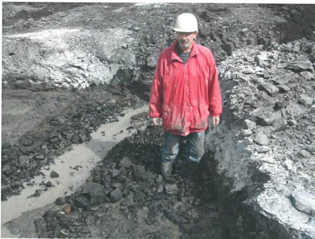
Obr. 7 - Zkouška únosnosti stabilizovaného retenčního kalu cca 30 min. po stabilizaci
