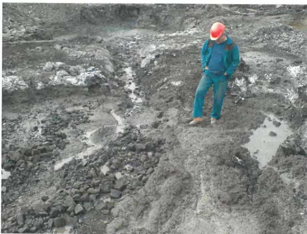
Obr. 8 - Povrch zkušební jímky po 4 dnech
