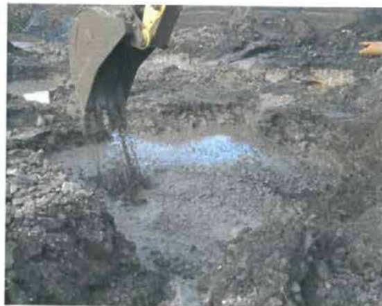
Obr. 2 - Homogenizace kalu v retenční jímce před nadávkováním stabilizátoru
