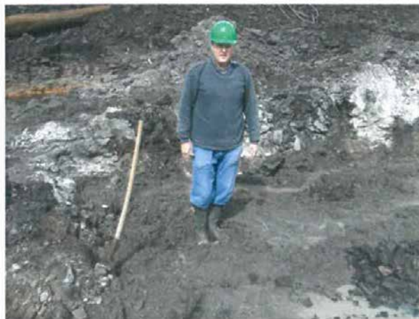
Obr. 6 - Zkouška únosnosti stabilizovaného retenčního kalu cca 30 min. po stabilizaci
