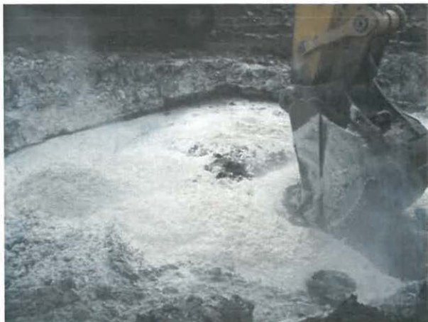
Obr. 3 - Dávkování stabilizátoru do simulované retenční jímky
