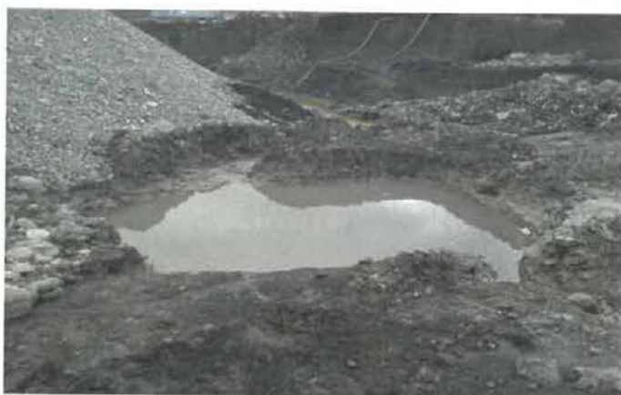
Obr. 1 - Pohled na připravenou zkušební jímku
