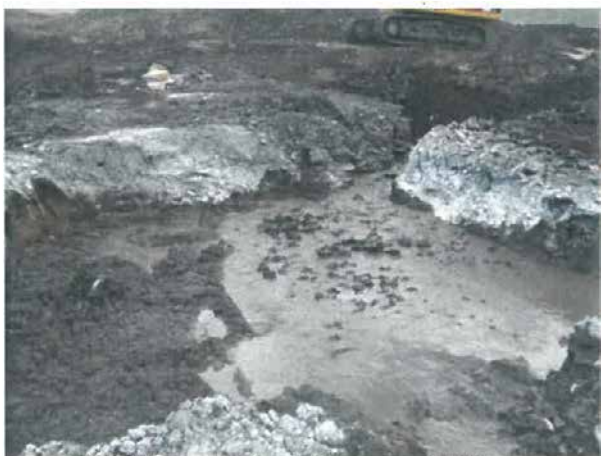
Obr. 5 - Zkušební jímka po obnoveném průtoku jímkou
