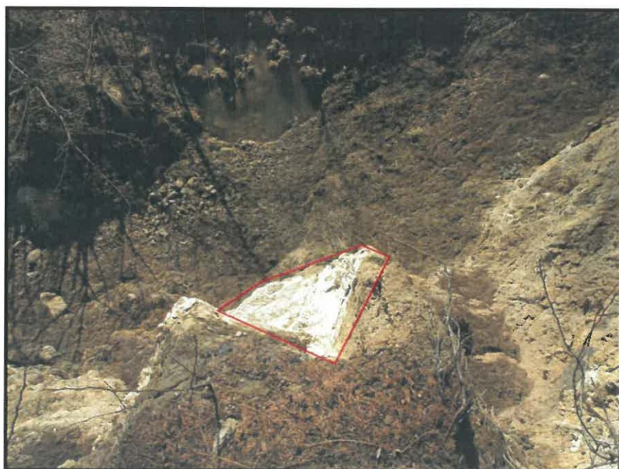
Obr. 5 – Franzschacht – půdorys zbytkového jámového stvolu
