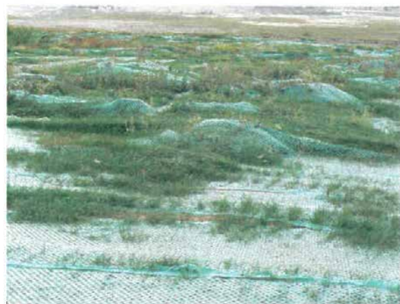
Obr. 2 – Vzednutí geotextilie růstem plevelů
