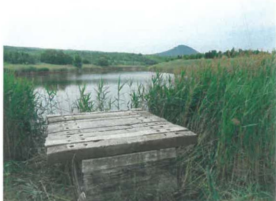
Obr. 5 – Výpusť vodní nádrže – odvodnění Střimické výsypky
