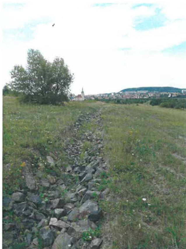
Obr. 7 – Odlehčovací příkop s kamenným záhozem
