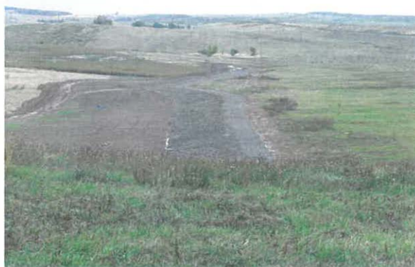
Obr. 4 – Opevnění a obvodová komunikace
