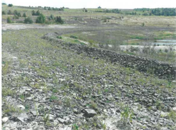
Obr. 3 – Opevnění břehové linie s rozrážečem
