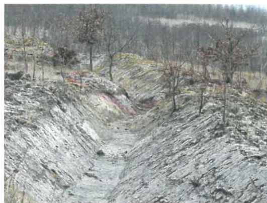
Obr. 6 – Výstavba odlehčovacího příkopu
