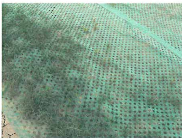
Obr. 1 – Perforovaná zatravnňovací geotextilie
