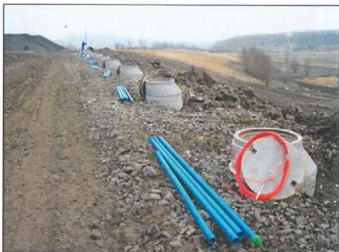
Obr. 12: Instalace technologie sifonové drenáže
