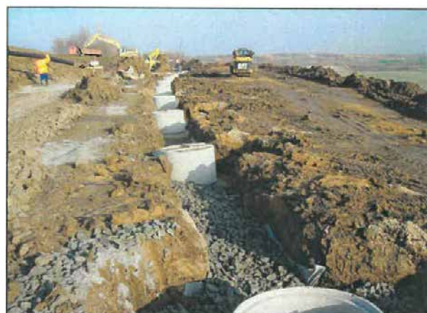
Obr. 10: Konstrukce drenážních řad
