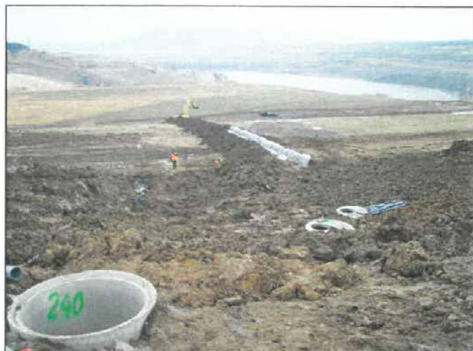
Obr. 14: Hloubení příkopů finálního odvedení zadržené vody
