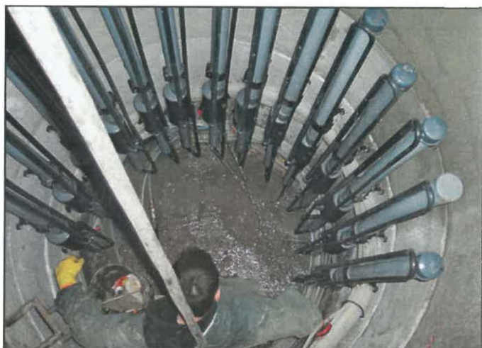
Obr. 13: Pohled do výtokové šachty
