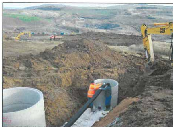
Obr. 11: Konstrukce výtokových šachet
