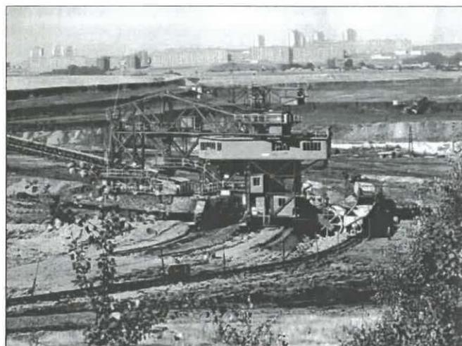
Obr. 6: Zakládání vnitřní výsypky Sylvestr v místě býv. Horního Rychnova, v pozadí Sokolov, kolem 1975. Zdroj: archiv SU.
