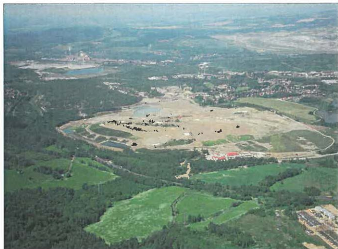
Obr. 9: Staveniště golfového hřiště na výsypce Silvestr. Foto J. Klimaj 2005.
