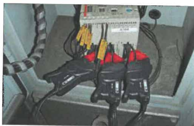
Obr. 3: Umístění proudových měničů
