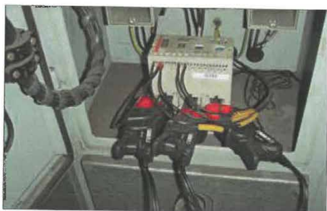
Obr. 3: Umístění proudových měničů
