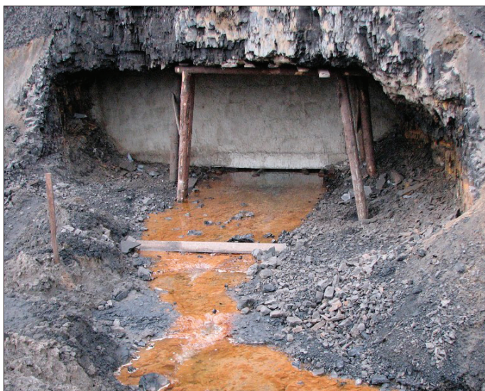
Obr. 16: Výtok vody z chodby na dně lomu Bílina pocházející z revíru dolu Venuše a nově budovaných svodových vrtů.
