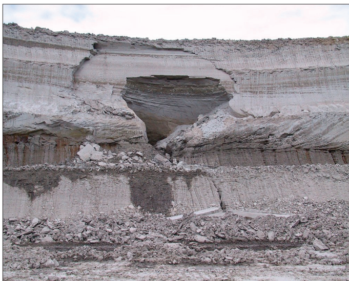
Obr. 7: Propadnutí stropu kaverny, vzniklé vyplavením písku u rýpadla K-65 na lomu Bílina. Foto: K. Mach.
