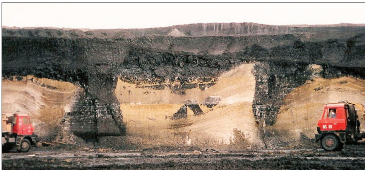
Obr. 4: Komory založené plavenou písčitou základkou na dole Masaryk (dnes lom Bílina). Foto: K. Mach.
