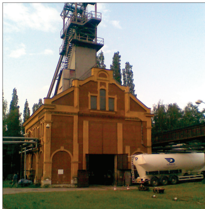
Obr. 3: Pohled na těžní budovu s jámou K 1 při dopravě popílku, určeného k likvidaci jámy, z přepravní cisterny.
