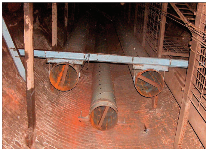
Obr. 6: Detail zakončení ochranných kolon v jámě MR 1. Foto: Palivový kombinát Ústí, s.p., archiv společnosti.
