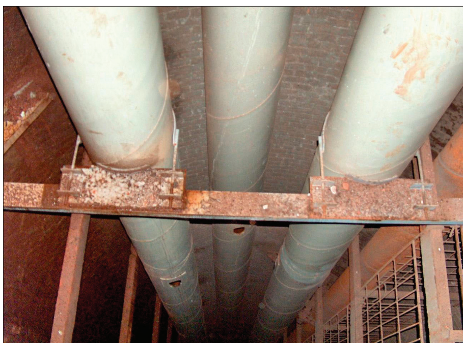
Obr. 5: Pohled na upevnění ochranných kolon v jámě MR 1. Foto: Palivový kombinát Ústí, s.p., archiv společnosti.
