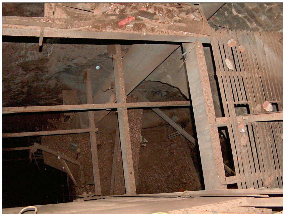
Obr. 4: Pohled do jámy MR 1 před instalací ochranných kolon. Foto: Palivový kombinát Ústí, s.p., archiv společnosti.
