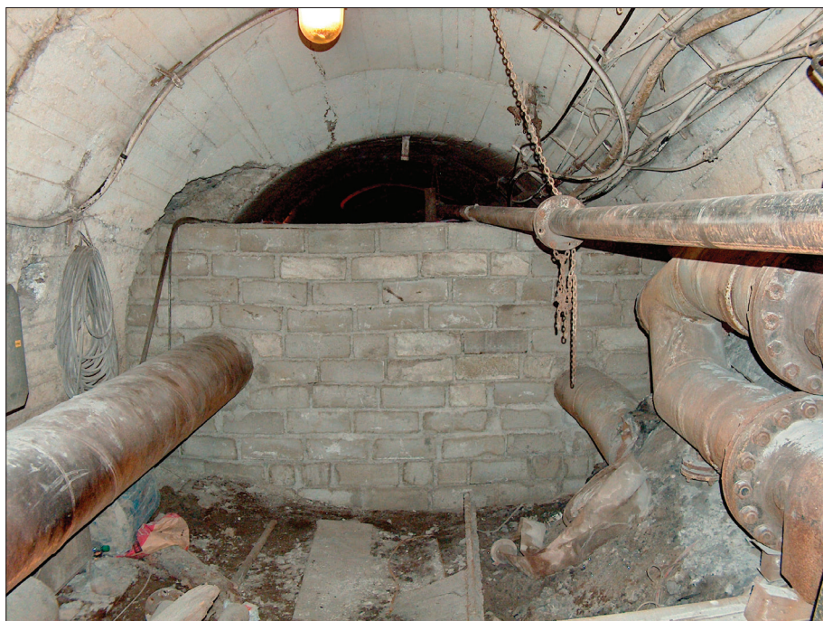
Obr. 2: Stavba hráže L 42 u jámy MR 1.
