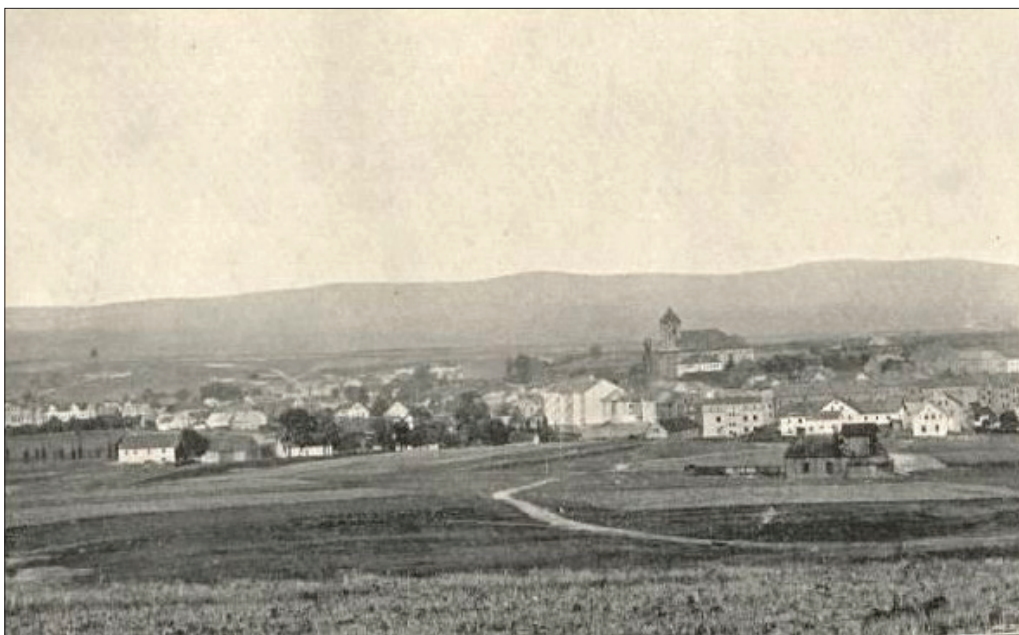
Obr. 2: Pohled na Chodov, v popředí větrná jáma v dolovém poli Vavřinec 1898.
