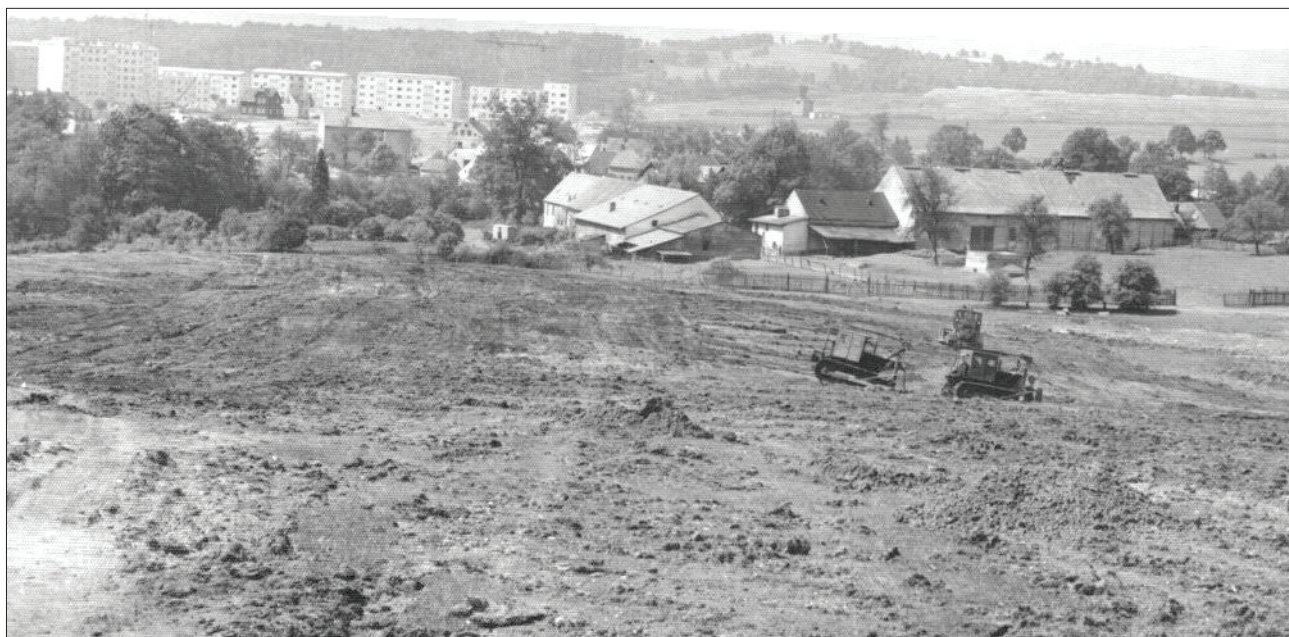
Obr. 5: Rekultivace devastovaných ploch nad bývalým Ritterovým dvorem, foto M. Babinec, 1961.
