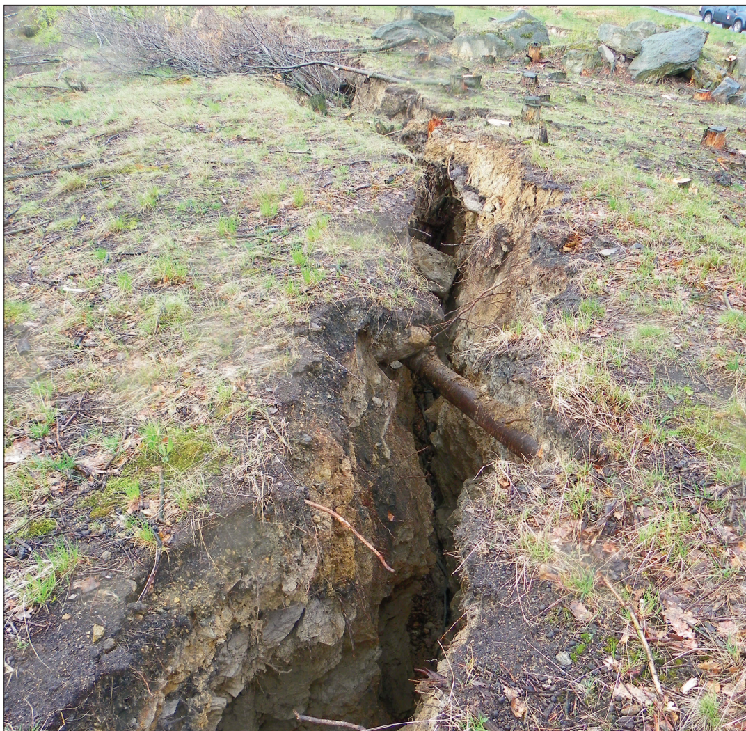
Obr. 5: Bývalé vodovodní potrubí obnažené v důsledku rozšíření odlučné oblasti. Přítomnost potrubí pravděpodobně ovlivnila některé ze sondážních křivek VES. (Foto: J. Burda, 2011).
