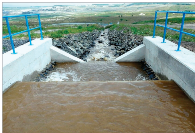
Obr. 5: Přítokový objekt do jezera Most - 10/2008. (Zdroj: www.pku.cz )
