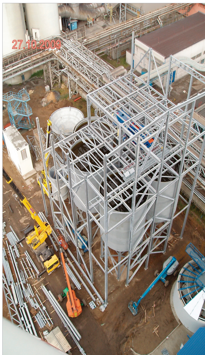
Obr. 9: Montáž nosné konstrukce objektu SOS, 16. 10. 2009.
