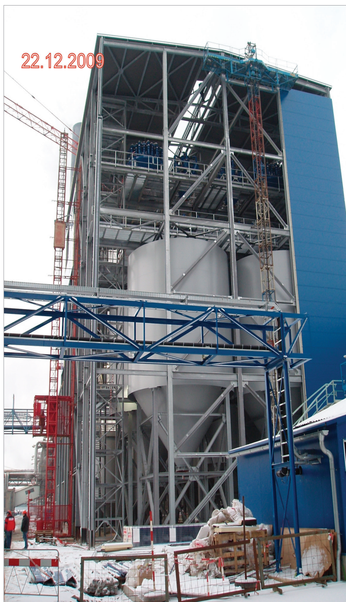
Obr. 10: Práce na opláštění objektu SOS, 22. 12. 2009.
