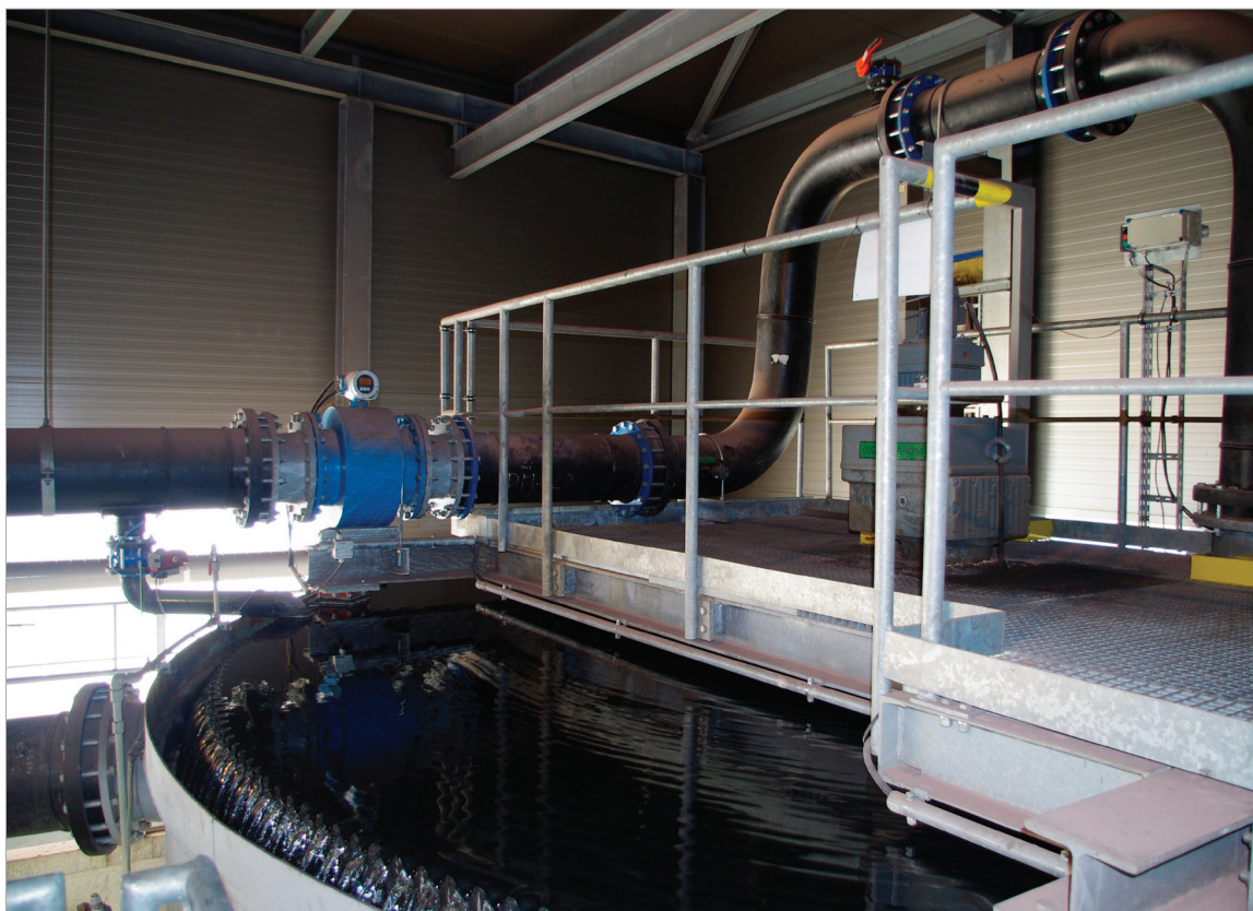
Obr. 1: Flokulační zásobník FZ I.
